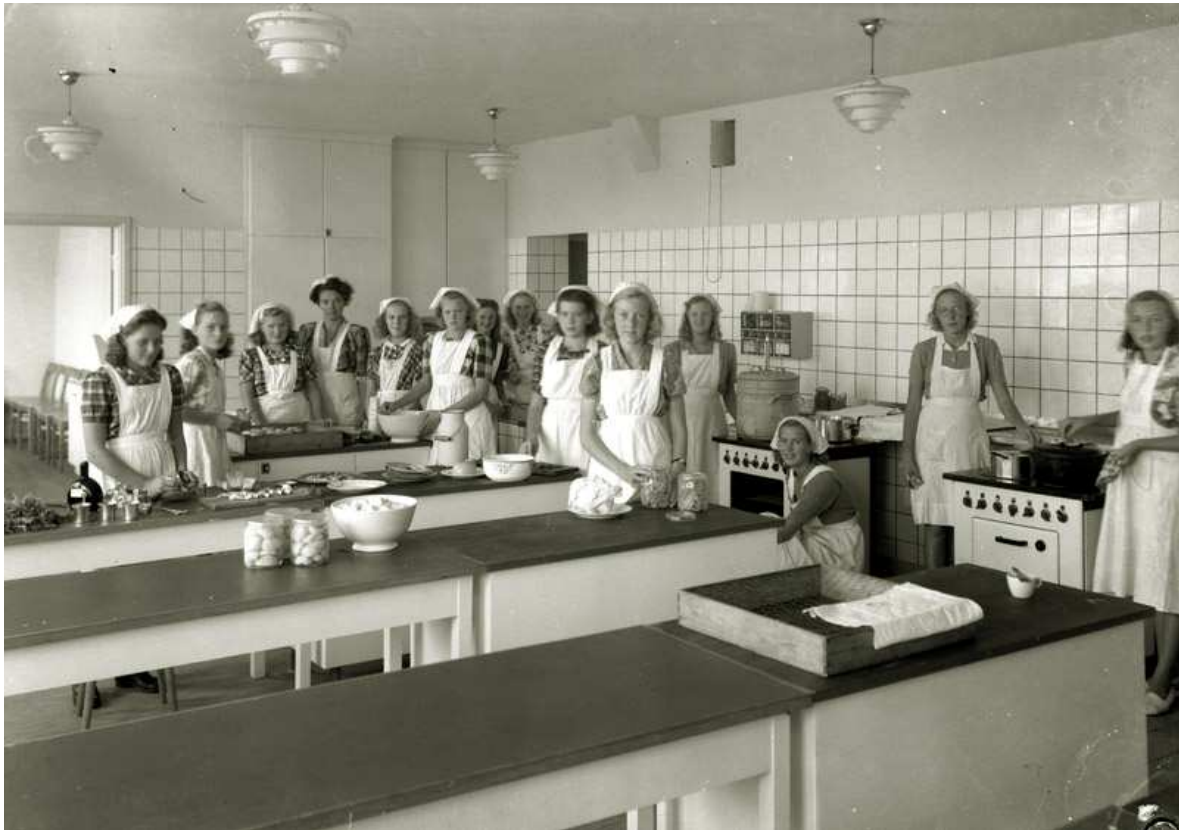
Skolköket år 1948, är någon av er läsare med på bilden hör gärna av er och berätta, foto: Hertzbergs Foto.
